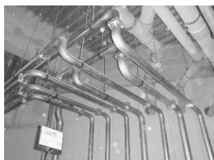
写真 7 雨水配管
